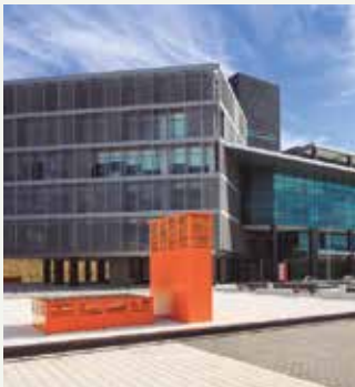
Technologiepark Andalusien in der Provinz Malaga. Bürogebäude mit hoher Energieeffizienz. Spanien. ECOi
