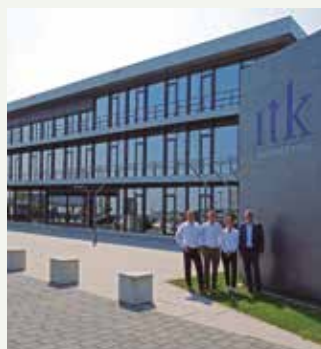
Innovatives Bürogebäude der ITK Engineering GmbH, Deutschland. ECOi und PACi
