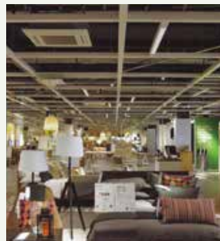
Neues „Click & Collect“-Einrichtungshaus von IKEA im Stadtzentrum. Birmingham, Großbritannien. ECOi und ECO G
