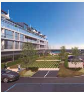
Marina Village in Greystones. Wohnkomplex mit 205 Wohnungen und 153 Häusern. Irland. Aquarea
